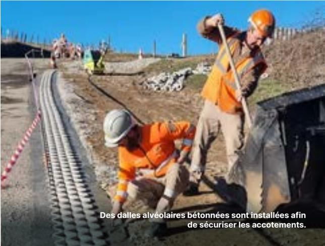
Des dalles alvéolaires bétonnées sont installées afin de sécuriser les accotements.
