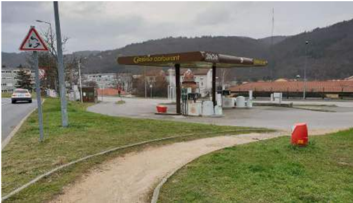
Vue sur la station essence, depuis la RD46, en direction du centre bourg
