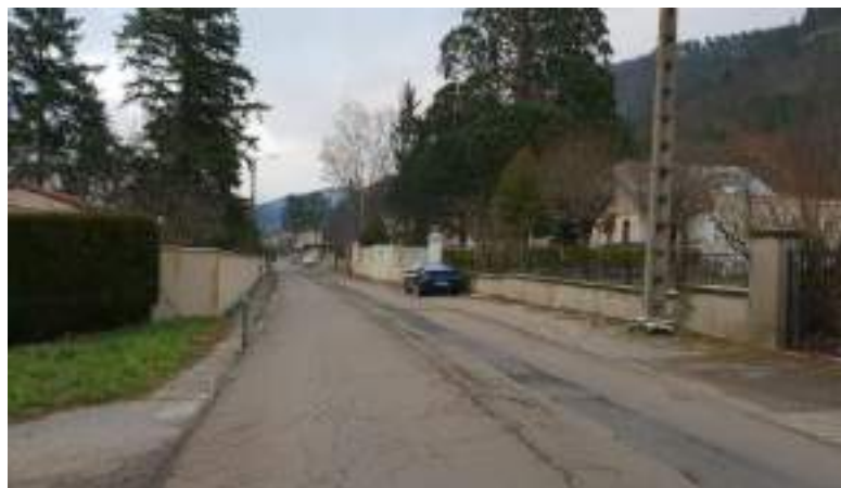
Rue des Ollagnières à hauteur de la parcelle n°157
