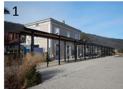
Le parvis de la gare (Source : Citadia)
