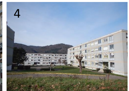
Le Secteur d’habitat collectif ( Source : Citadia)
